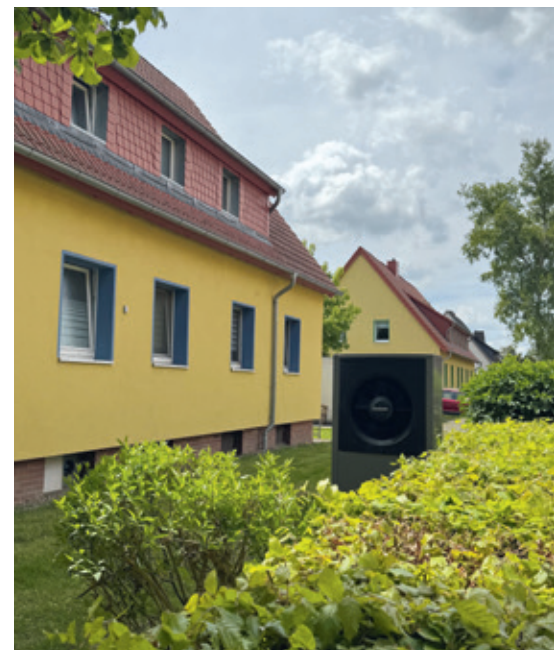
„Am Grundbach 51“: dezentrale Versorgung mit Luft-Wasser-Wärmepumpen
