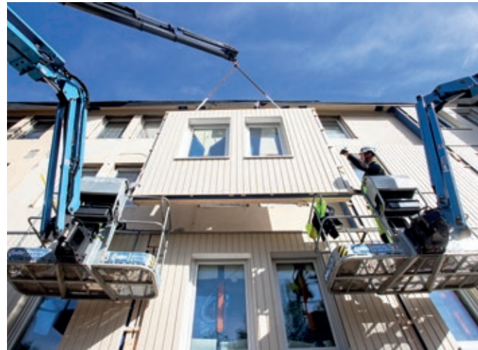
Großflächige Teile der Holzfassaden werden angeliefert und in einem Schritt am zu sanierenden Gebäude angebracht.
