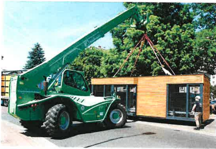
In einem Pilotprojekt in Maintal-Bischofsheim installierte die NHW neun Energiemodule mit effizienter Wärmepumpen-Technik und effektiver Speicher-Technologie
